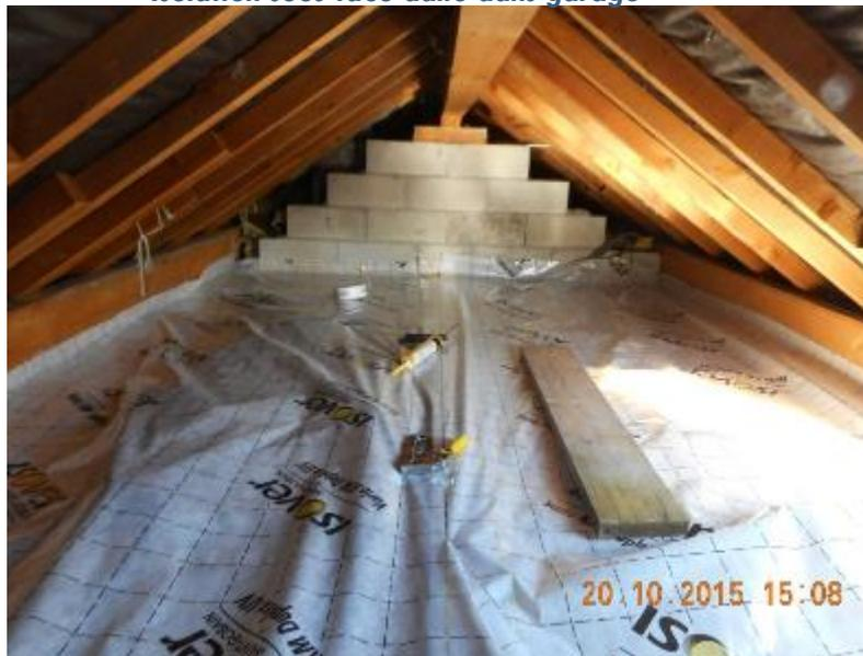
*Isolation plancher haut avec membrane d'étanchéité à l'air*
