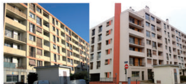
Rénovation d'une copropriété à Villeurbanne (69)
