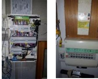
Figure 1-10 : Photographie du système de mesure Multivoies/tableau électrique –tableau ouvert (gauche) et tableau fermé (droite).
