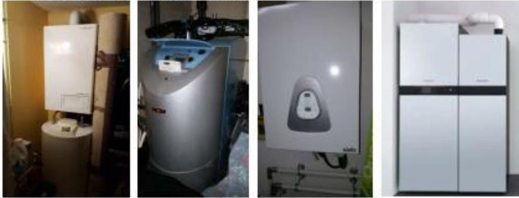
Figure 12-9 : Photographies de chaudières – De gauche à droite : chaudières gaz, fioul, électrique et cogénération gaz.
