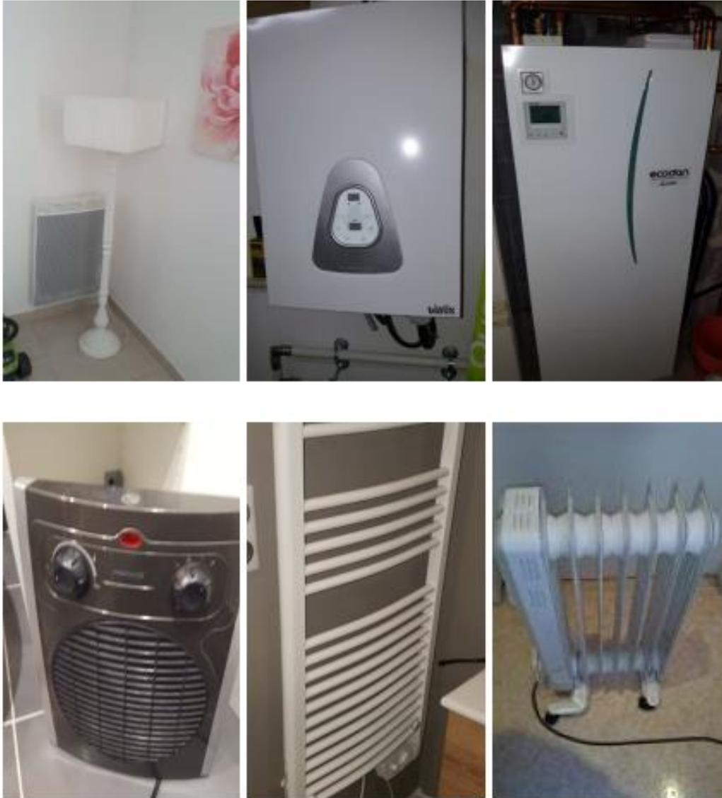
Figure 9-2 : Photographies d'équipements du poste chauffage électrique. De haut en bas et de gauche à droite : convecteur électrique, chaudière électrique, PAC, soufflant électrique, sèche-serviette électrique, radiateur bain d'huile sur prise.
