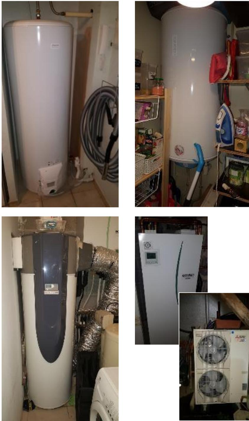
Figure 10-2 - Photographies d'équipements du poste ECS électrique. De haut en bas et de droite à gauche : chauffe-eau à effet joule sur pied (300L), chauffe-eau à effet joule mural (100L), chauffe-eau thermodynamique sur air intérieur (270L), PAC double service sur air extérieur.
