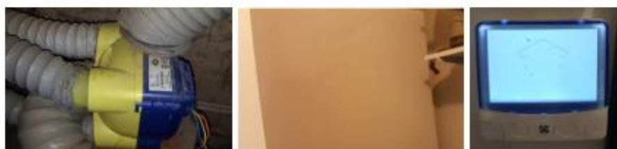
Figure 12-2 : Photographie d'un caisson de ventilation simple flux (gauche) et d'un caisson double flux avec sa commande (centre et droite)
