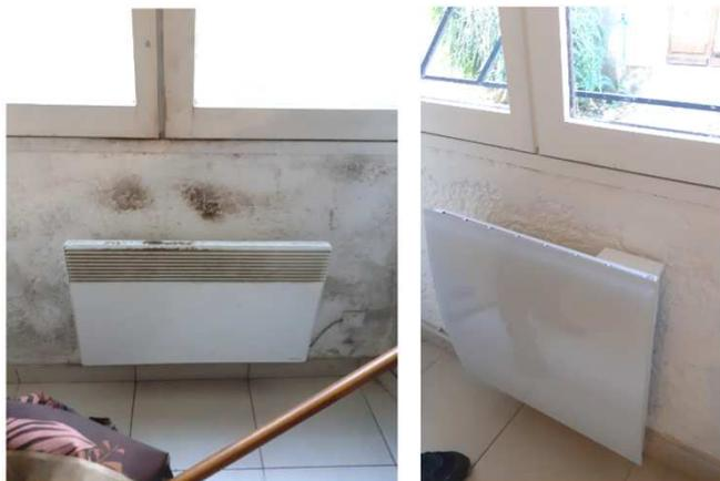
Remplacement des convecteurs par des radiateurs à inertie programmables
