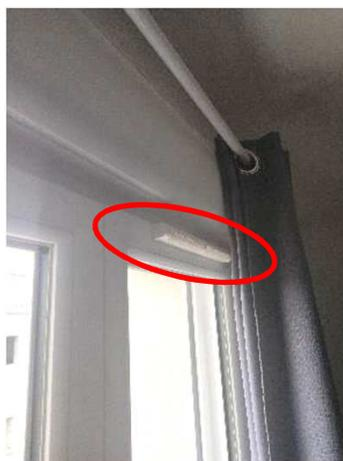
Joint du bac à douche entièrement repris et installation d'entrée d'air en pièces sèches
