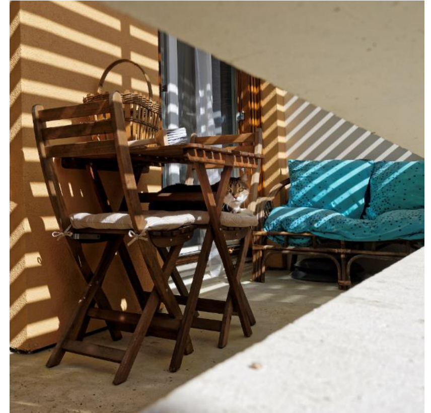
Les brise-soleil à RDC couvrent l'intégralité : perte de lumière naturelle en hiver mais forte protection complémentaire en été, très appréciée.
